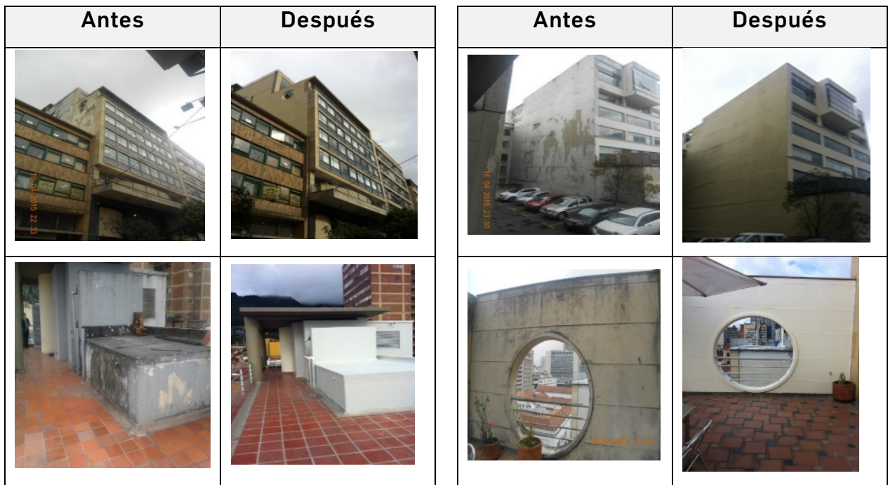
Imagen 9. Mantenimiento culatas y fachadas del edificio
