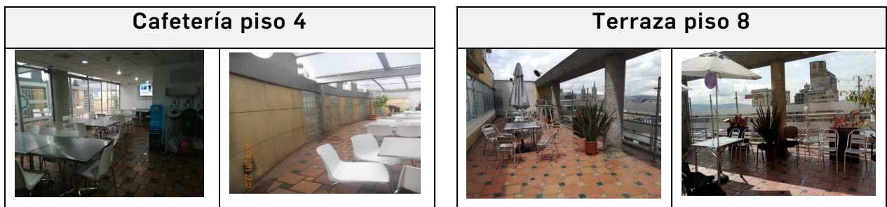
Imagen 7. Adecuaciones cafetería piso 4 y adquisición e instalación mobiliario en la terraza del piso 8
